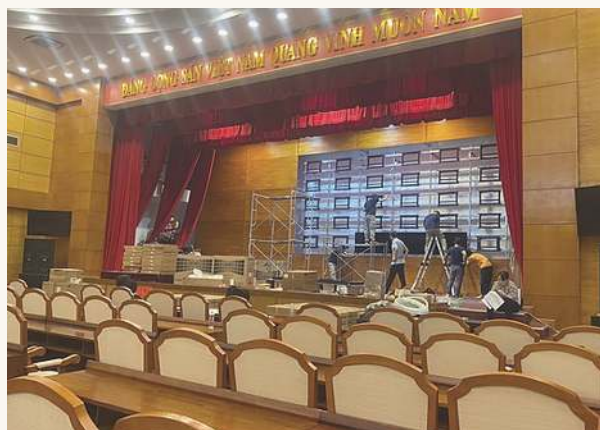
— Thi công hệ thống trình chiếu tại hội trường
